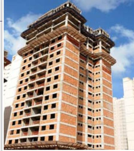
**BLOCO C** - Está em execução a estrutura de concreto que será concluída até o final do mês de julho. Paralelamente, correm os serviços de alvenarias, instalações de tubulações elétricas e hidráulicas, contrapisos e chapisco interno. Foi iniciada no dia 21 a escolha das cerâmicas, que se estenderá até o dia 5 de junho.
